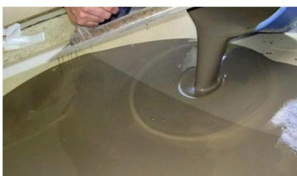
دقت در اندازه گیری آب رعایت شود. عدم دقت در اندازه گیری آب باعث دیرگیری و افت مقاومت می‌شود. عرض لبه‌های آزاد پلیت حداقل ۵ سانتیمتر باشد تا از ترک خوردگی ناشی از انبساط طولی جلوگیری شود. حداقل ضخامت گروت ریزی در یک مرحله نباید بیشتر از ۱۵ سانتیمتر باشد. پس از احرای گروت عمل کیورنگ به وسیله رطوبت الزامی است. سطح فونداسیون مورد اجرا باید عاری از روغن، گریس و یا مواد سست باشد. قبل از دوغاب ریزی سطح مورد نظر باید کاملاً پاک و تمام سوراخها و محفظه‌ها با فشار باد تمیز گردد.
